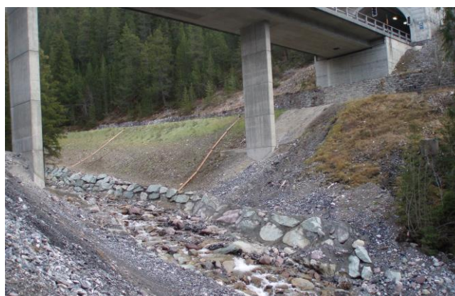
Wiederhergestelltes Bachbett, gesicherter Pfeiler
