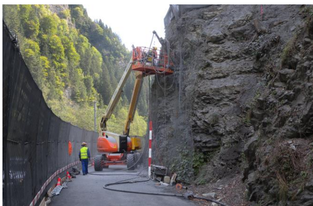
Bohrarbeiten Steinschlagschutznetze mit Hebebühnen
