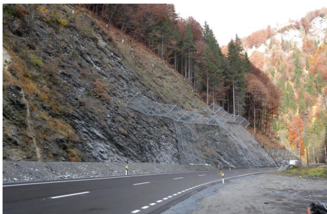
Fertiggestellte Schutzmassnahmen im Gebiet Auli 2
