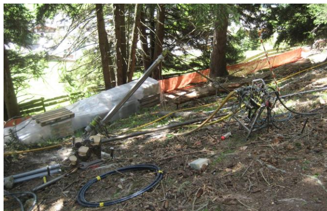
Bohren der seitlichen Abspannungen
