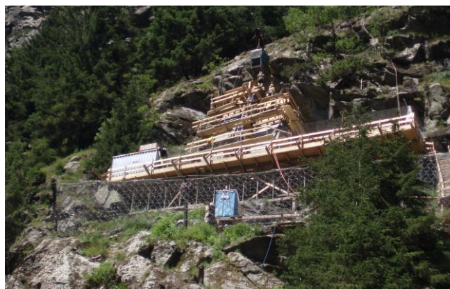
Betonierarbeiten Pfeiler B
