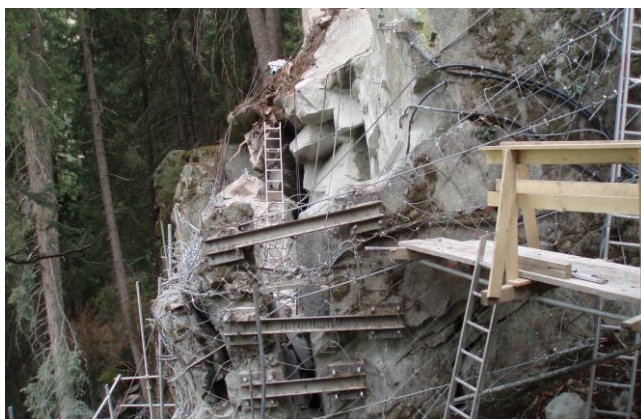
Felsabbau mit temporären Sicherungen
