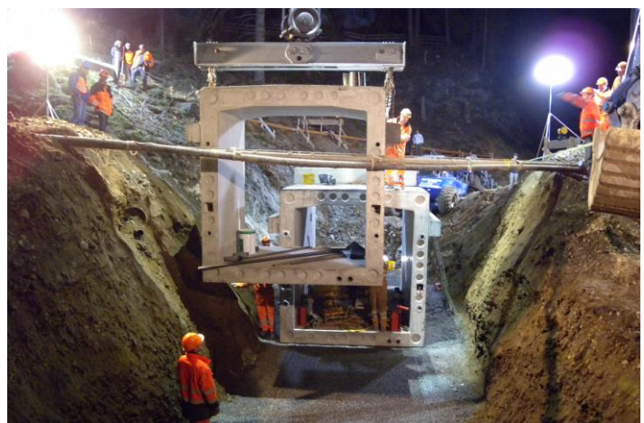
Präzisionseinbau Betonelemente
